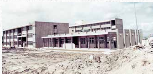
完成直後の旧3号館。奥に5号館
