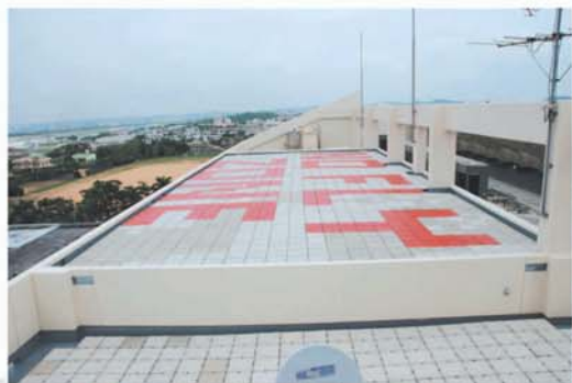
本館屋上の「NO FLY ZONE」文字のペイント
