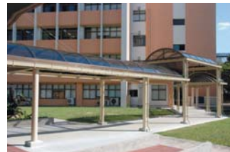
9号館、厚生会館側渡り廊下
