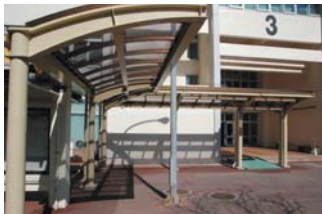
本館、3号館側渡り廊下
